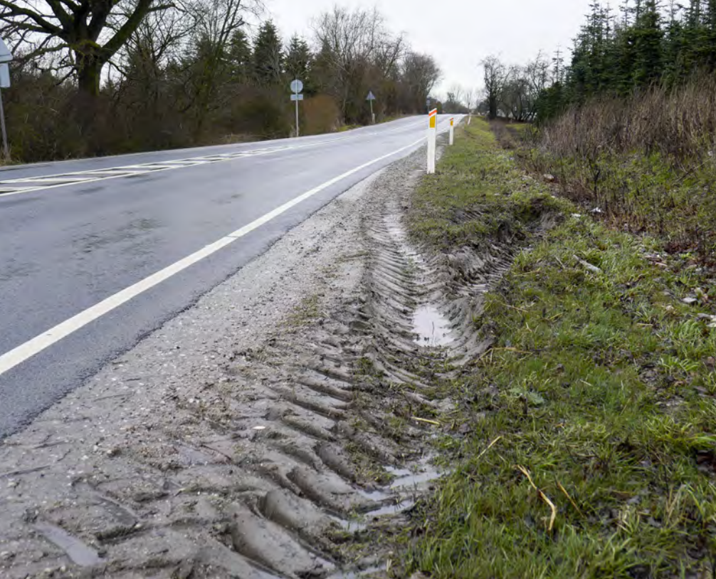
Figur 1. Blød rabat. Rabatskader påvirker trafikanters mulighed for at genvinde herredømmet.
