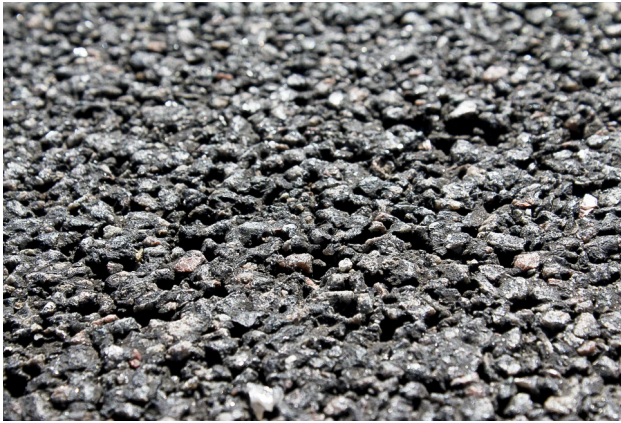
Figur 2. Nærbillede af mørtel- og stentab.
