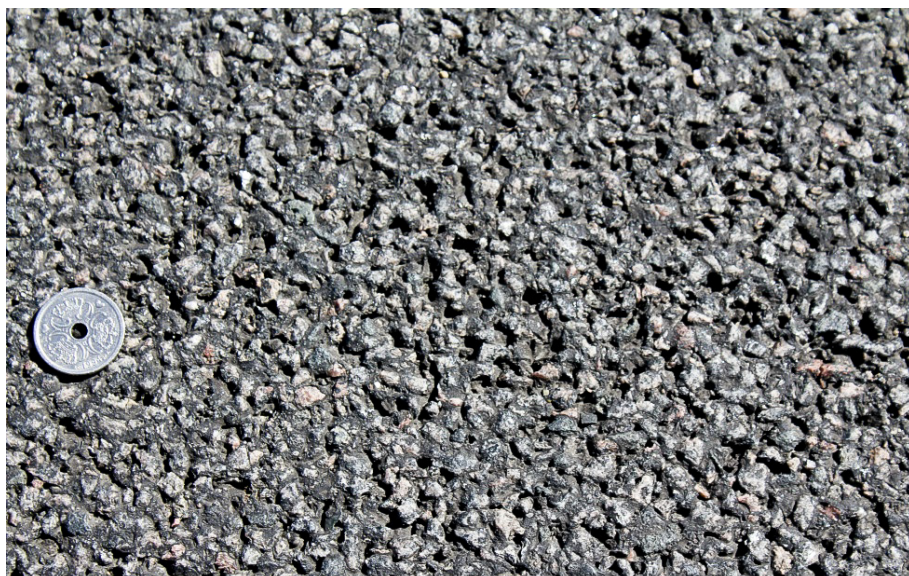
Figur 1. Billede af mørtel- og stentab. De sorte huller skyldes afrevne sten, og flere steder er stenene blottede pga. mørteltab.
