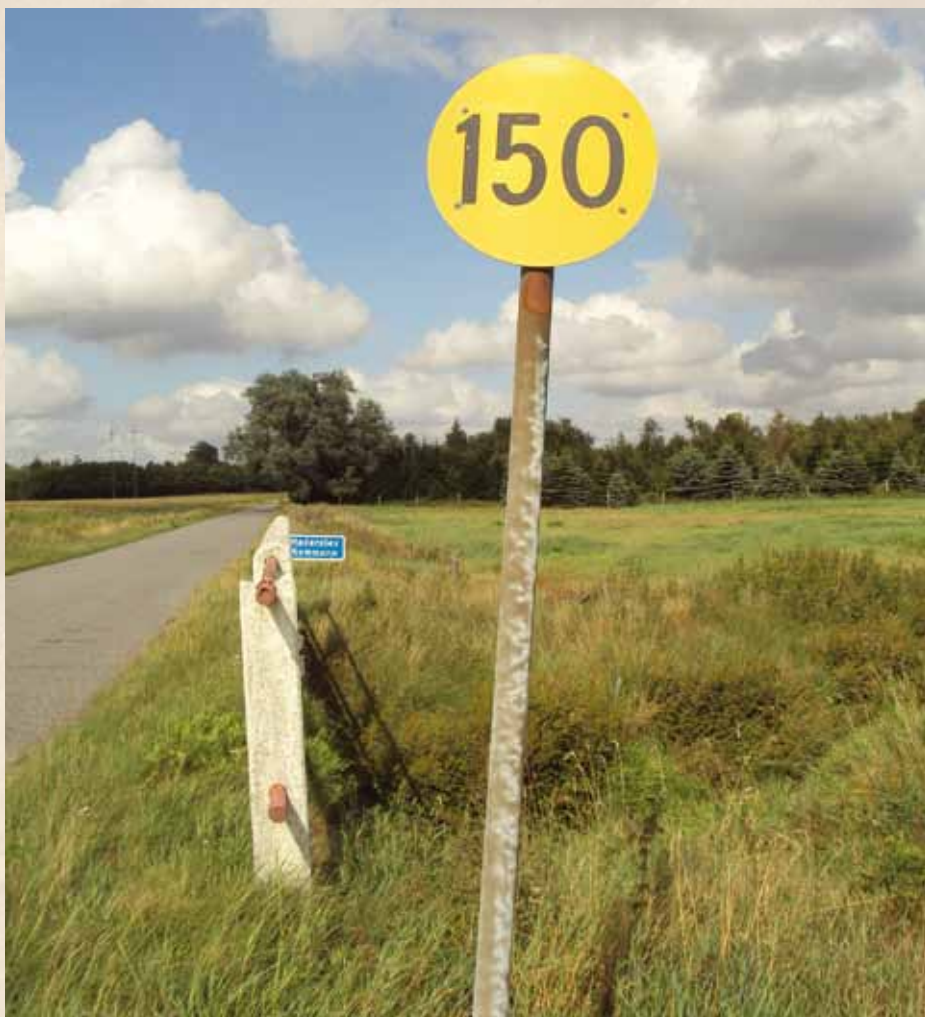
Figur 4. NATO-klassifikationskiltet på "omfartsvejen" med de 150 (tons) tilladte belastning.
