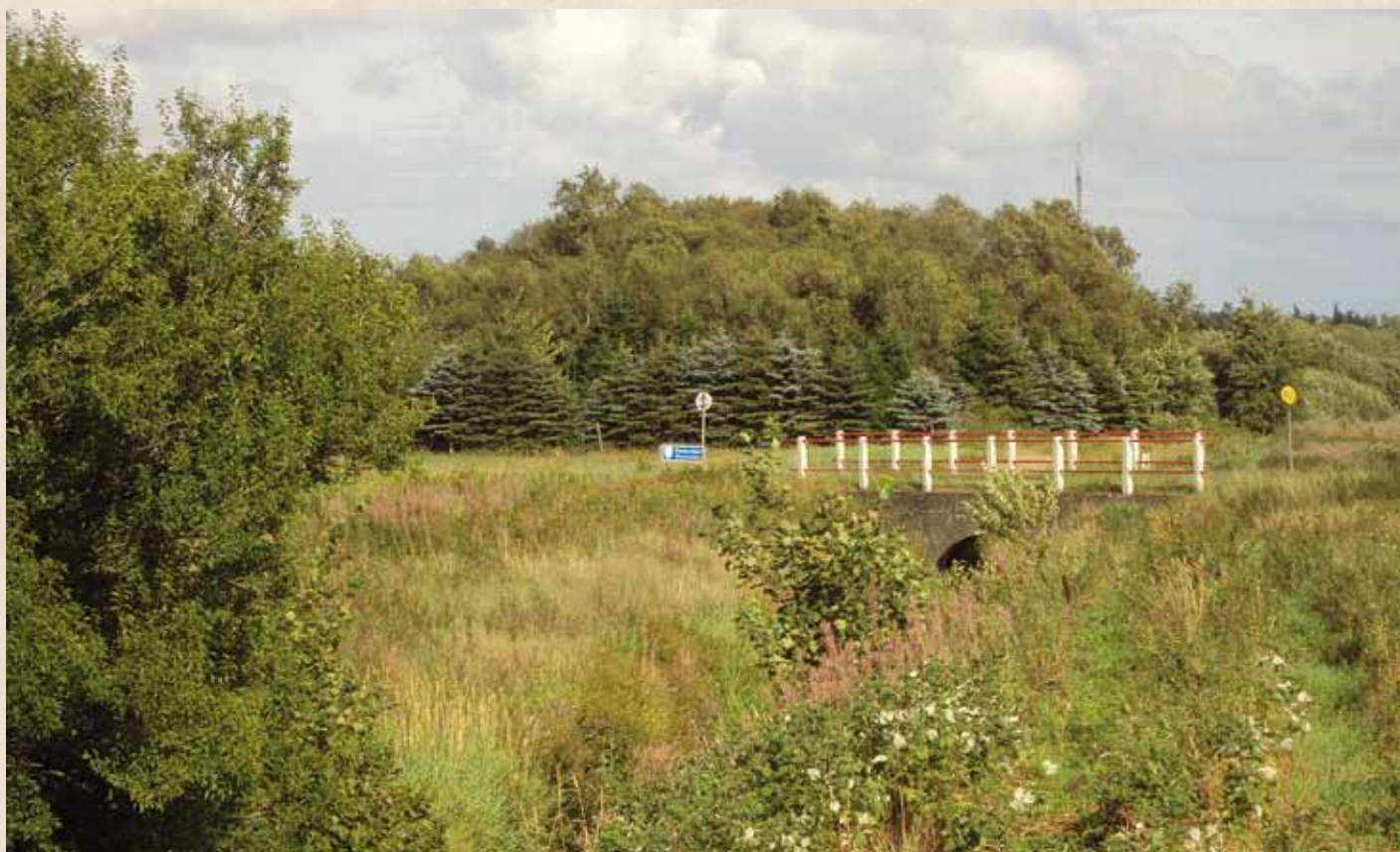
Figur 3. Den nye betonbuebro ved "omfartsvejen".
