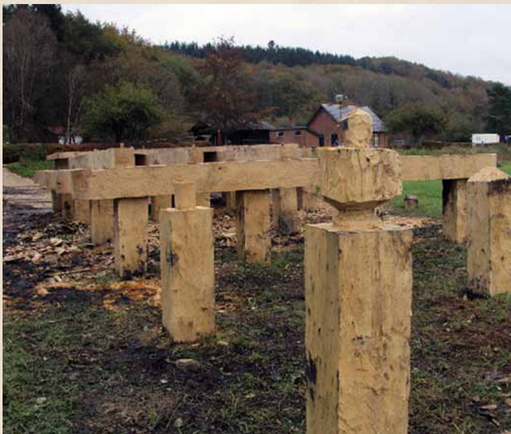
Figur 2. Detalje af rekonstruktionen. Vikingetidens ingeniørsoldater brugte ikke sav, men beherskede teknikken med økse, så de kunne tilhugge pælene helt nøjagtigt, som var de savet af. De pudsige pælehoveder, der blev afhugget ved tilpasningen, er der fundet en del af i forbindelse med udgravningen. I baggrunden skimtes den gamle bygning for Ravning station på Vandelbanen. Det er nu bromuseum.
