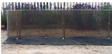
Figur 1. Vejsideværn i polykarbonat kanalplade på aluminiumsbukke.
