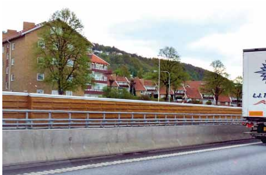
Figur 1. Boligbebyggelsen ved Husqvarna med støjskærm og støjreducerende to-lag drænasfalt.
