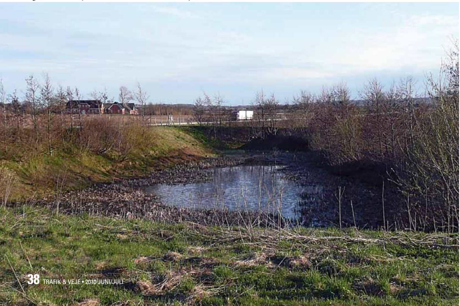
Figur 1. Et vådt vejvandsbassin ved en dansk motorvej.
