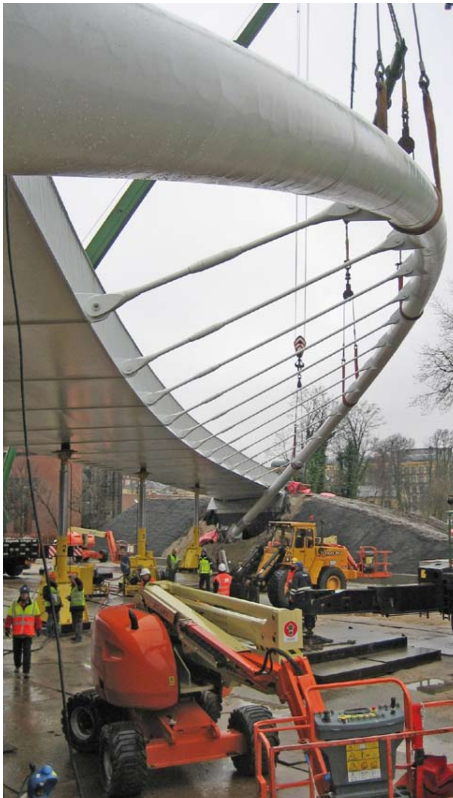
Figur 9. Brodrager, bue og trækstag er monteret og endnu "spændingsløse". Herefter sænkes de hydrauliske donkrafte og broen spænder frit. Foto NIRAS.
