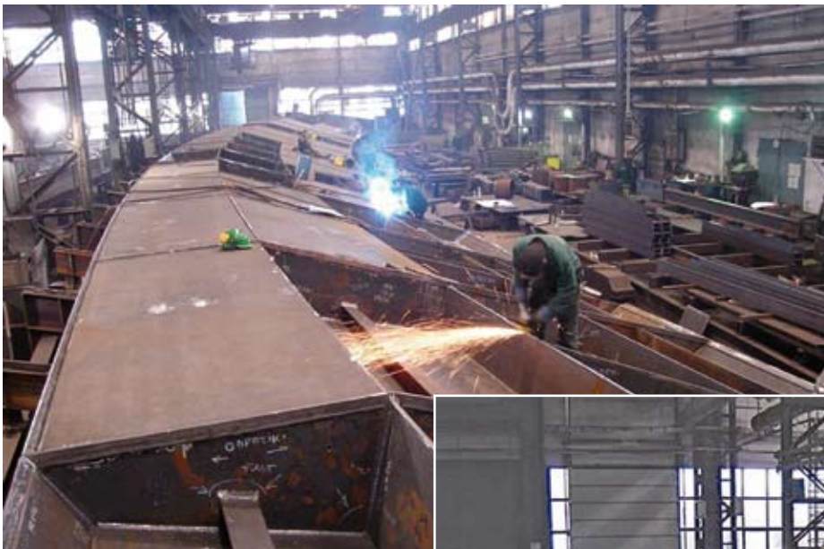
Figur 6. Hele brodrageren under opbygning hos smeden i Polen. Brodrageren er opbygget af kegleflader med plader på op til 30 mm's tykkelse. Brodrageren bliver her opsvejt på hovedet, delt i to dele på tværs og i 3 dele på langs. Efterfølgende fragtes de til Ågade og sammensvejses retvendt. Foto Bladt.
