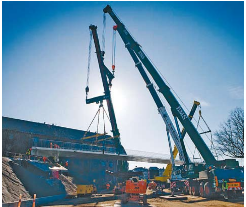
Figur 8. Brodrager på 220 tons løftes på plads med fire store mobilkraner. Foto Jon Norddahl.
