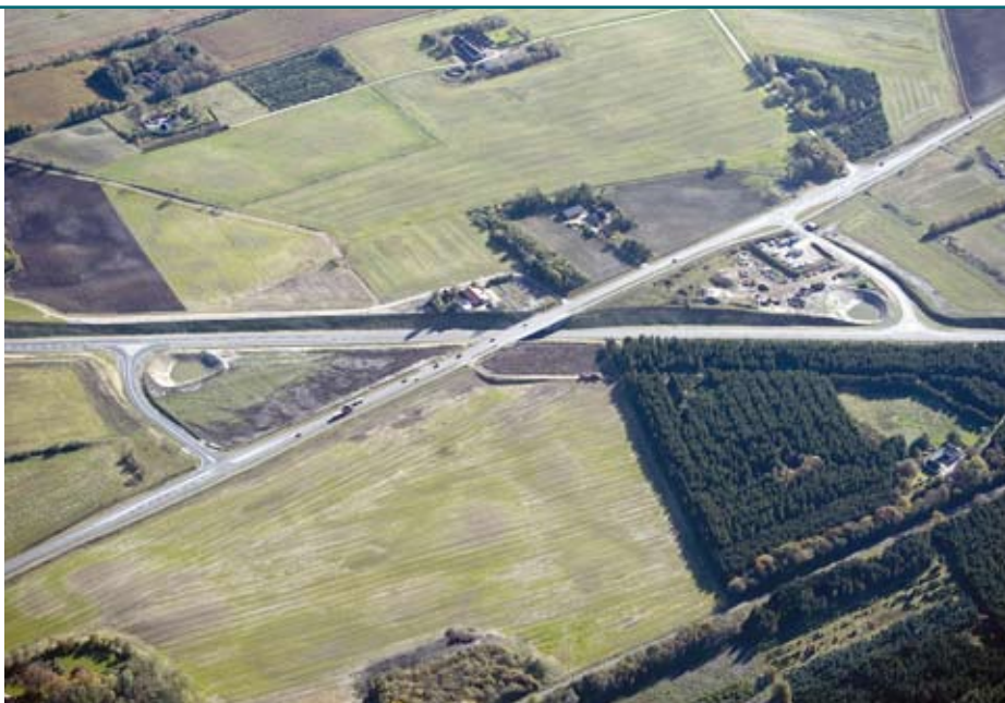
Hankeanlægget ved Tyk højvej.
