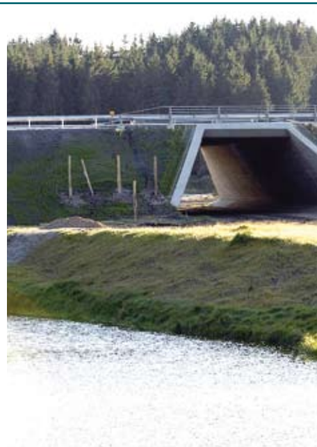
Regnvandsbassin placeret ud for faunaunderføring.
