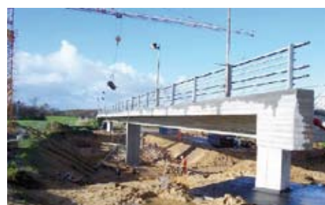
SCC-demobro efter afforskalling. Foto: Gim-sing & Madsen, oktober 2006.
