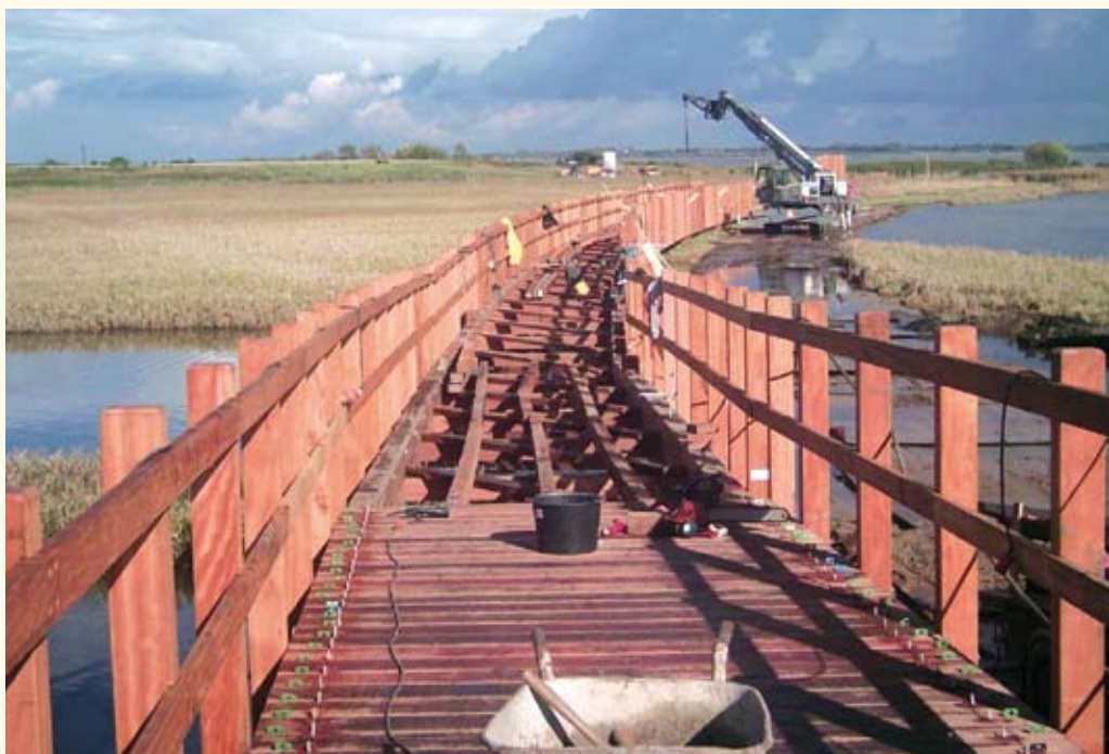
Figur 5. Dækplanker monteres.
