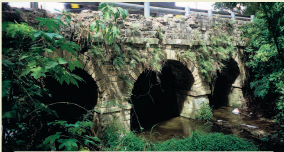
Figur 5. Broen fra 1909 er opført af vejinspektør Ejnar Kærn. Broen er konstrueret af tilhugede koralsten. Foto: Arne Rosenkvist.
