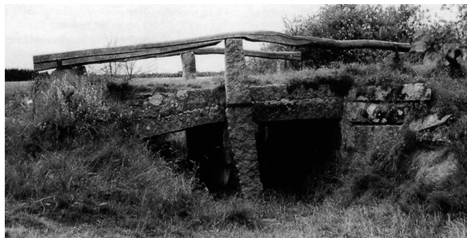
Immervad Bro, stenbro fra 1787 fører Hærvejen over Immervad Å. Afvanding og vandstandssænkning har bevirket, at åen har et nyt leje, så broen i dag er tørlagt. (Ill. fra Danmarks Vej- og Bromuseum).
