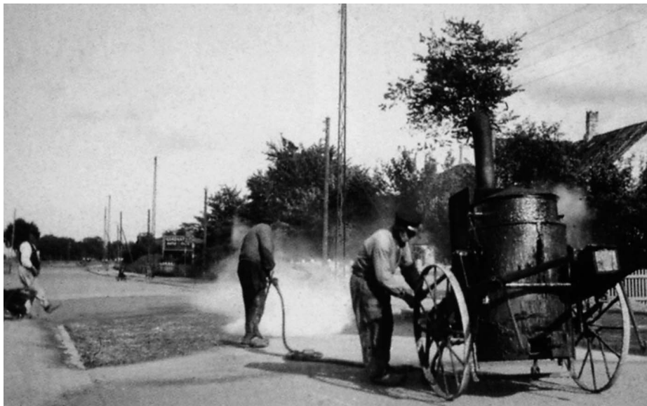
Overfladebehandling af landevej i 1920'erne. (Ill. fra Danmarks Vej- og Bromuseum).
