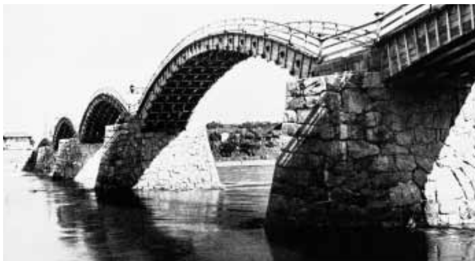
Kintai-kyo har en samlet længde på 195,7 m og er 5,0 m bred. Den består af 5 buer, alle på ca. 35 m's længde, samt pilleskifter og landfæster af sten. Postkort fra 1950'erne.
