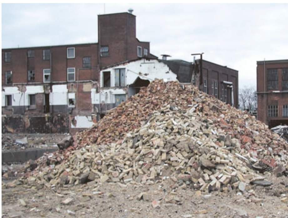
Figur 3. Tegl og murværk fra nedrivning.
