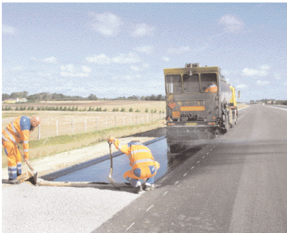
Nødsporet blev udlagt med 1.000 tons pr. dag – svarende til 2,5 km.
