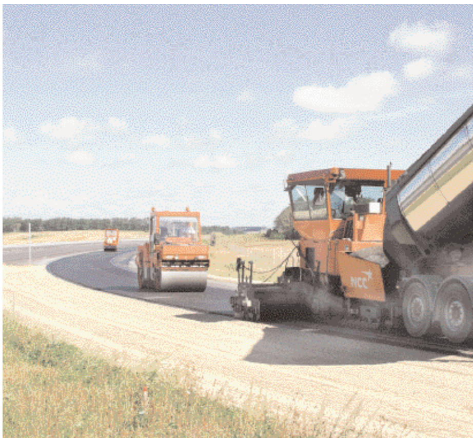
Der blev udlagt en samlet mængde på 220.000 tons asfalt.
