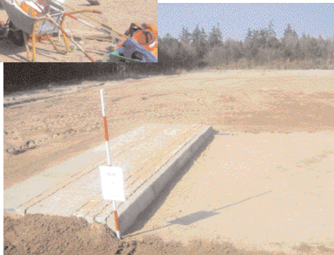
Figur 2. Entreprenøropgave med hhv. udlægning af stabil grus, udførelse af fortov og den færdigudførte entreprenøropgave.
