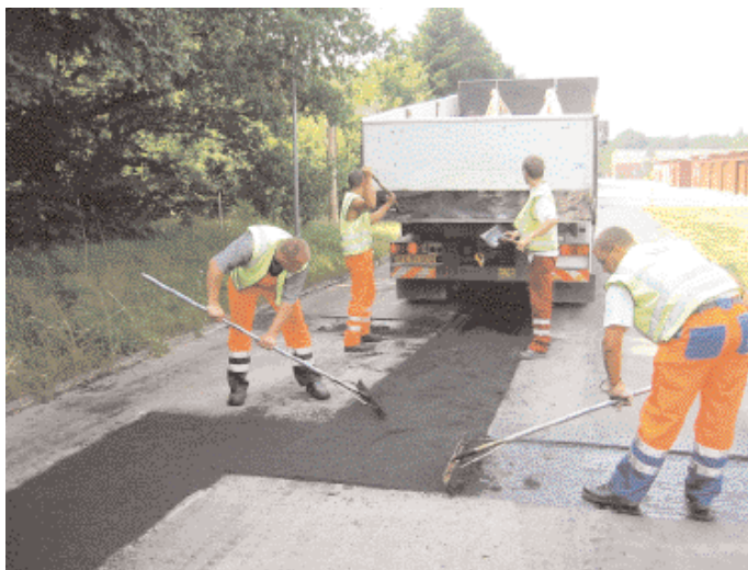
Figur 1. Asfaltopgave med henholdsvis hånd- og maskinudlægning.
