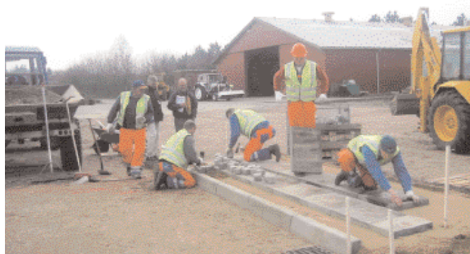
Figur 2. Entreprenøropgave med hhv. udlægning af stabil grus, udførelse af fortov og den færdigudførte entreprenøropgave.
