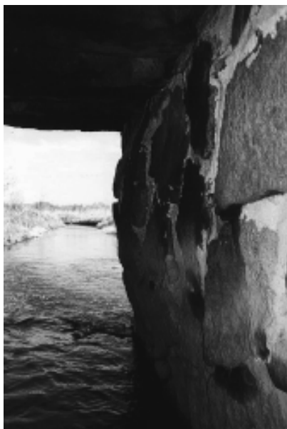
Figur 2. Udbuling på den ene strømpille.
