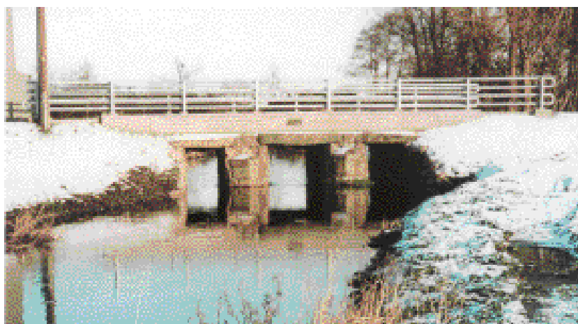
Figur 6. Nybro efter ibrugtagning.
