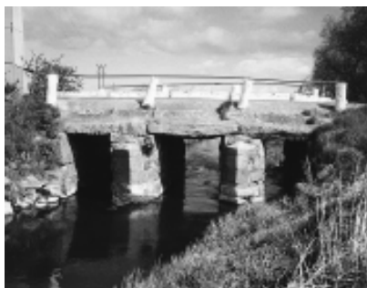
Figur 1. Nybro over Tuse Å før restaurering.
