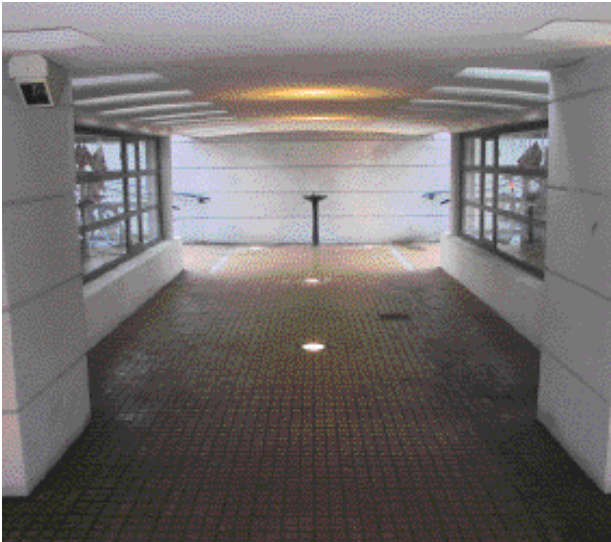
Figur 4. Den gamle banegård – Udgang fra tunnel.
