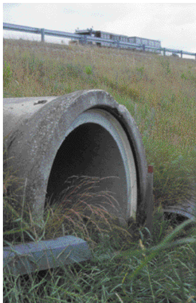
Figur 2. Kloakrør af armeret beton (passage) og kraftig plast (hegn) opstillet på rute 267, motortrafikvejen nordvest for Hillerød. (Foto: Tove Hels)
