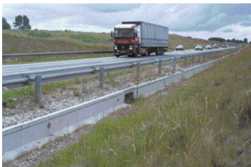
Figur 3. Lave firkantede betonelementer, specielt fremstillede til faunapassage, med ledehegn af beton. Passage og hegn fungerer som én enhed, og der kommer ikke sprækker imellem passage og hegn. (Foto: Tove Hels)
