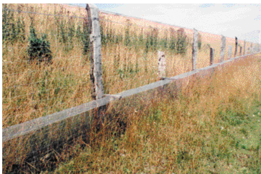
Figur 4. Banestyrelsens permanente hegn på Sprogø. Hegnet er ca. 40 cm højt, er gravet ca. 10 cm ned i jorden og har en ombukket kant, så tudserne ikke så let kan kravle over det. Hegnet står op ad et traditionelt vildthegegn. (Foto: John Frisenvænge)
